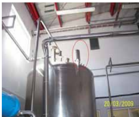
Танк за съхранение на вода, оборудван с въздушен филтър
