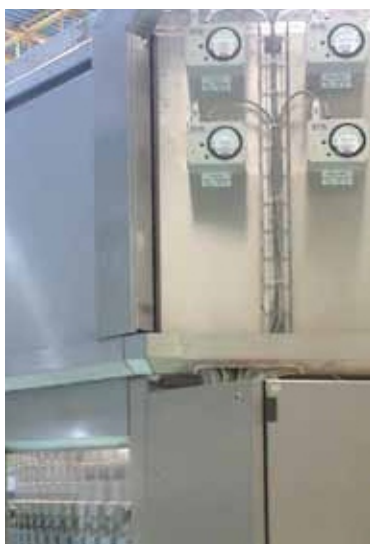
Оборудване за измерване на налягането към пълначната камера
